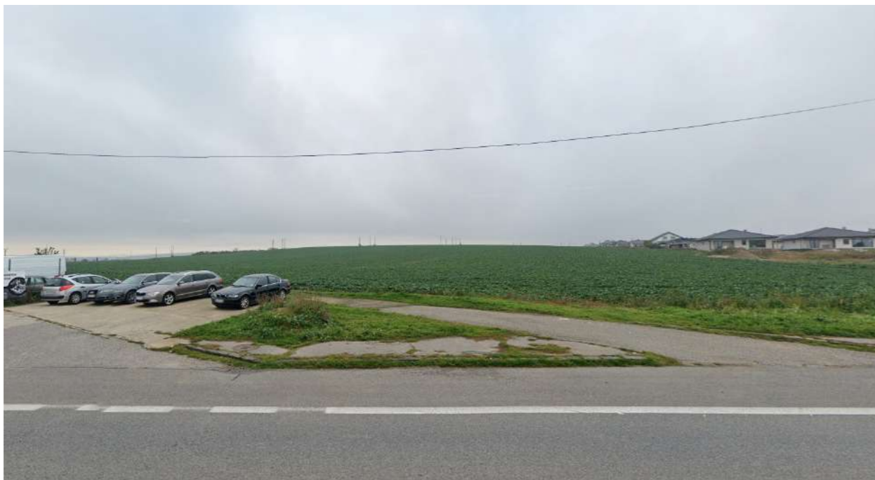
pohľad na riešené územie z cesty smerom na Skalicu
